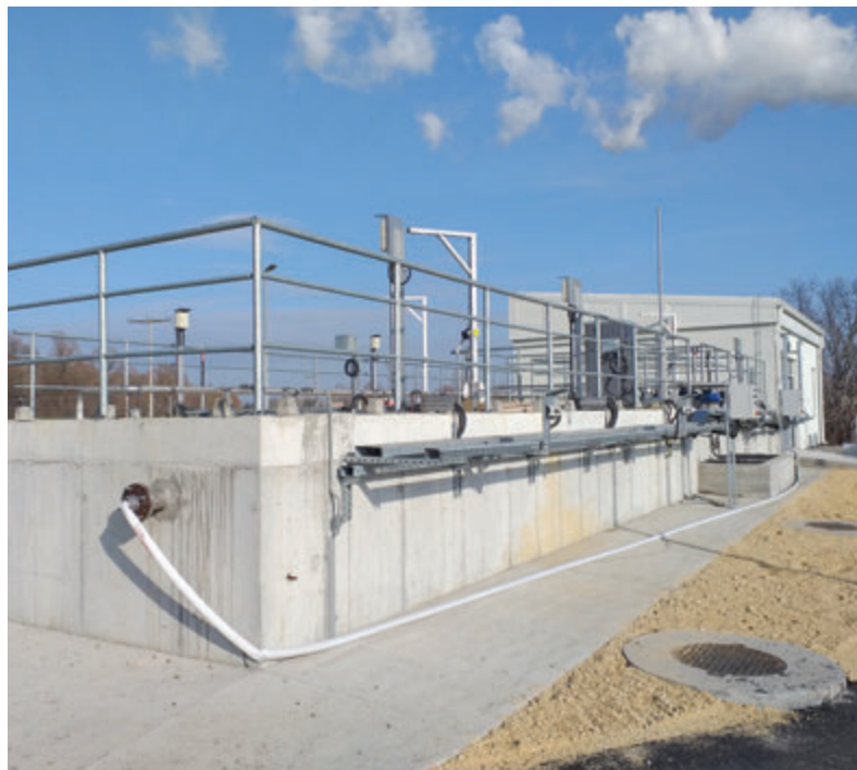
■ Постројење за пречишћавање санитарних отпадних вода
